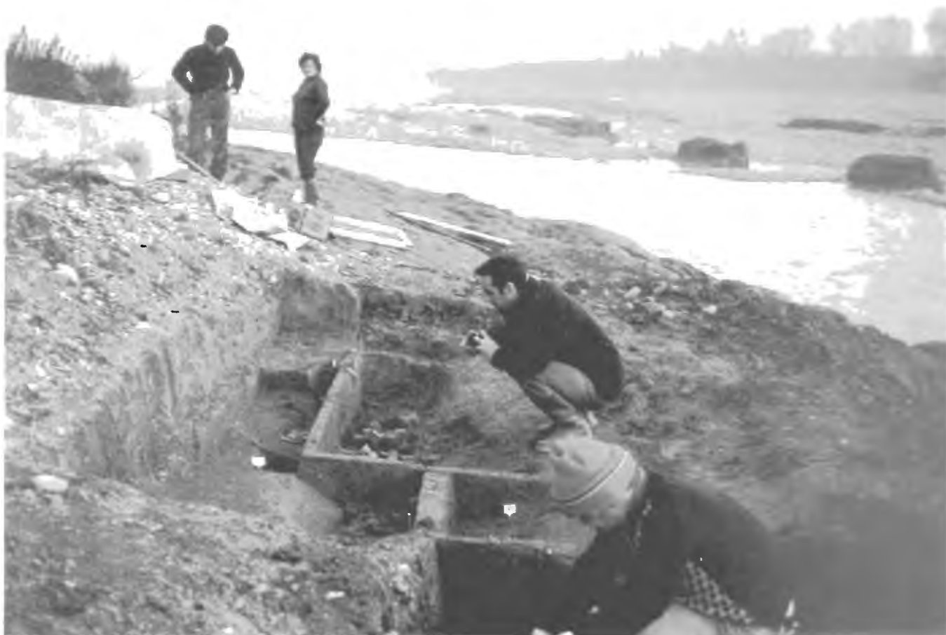
14 - Lavori di recupero nell'area X.
